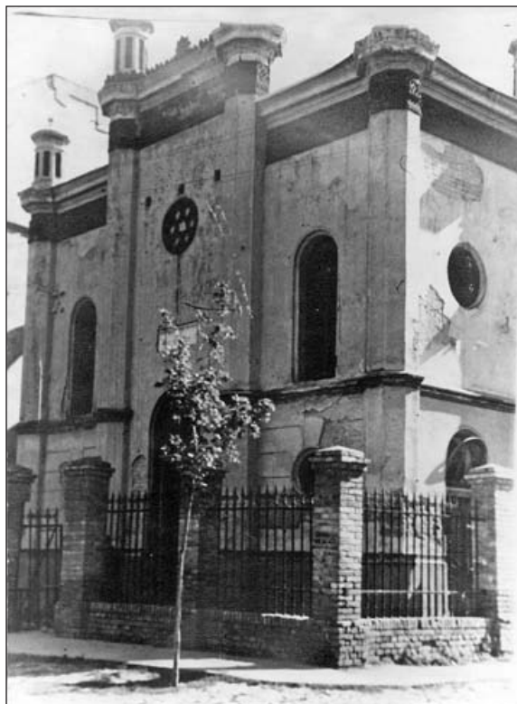
29. Oštećena sefardska sinagoga
